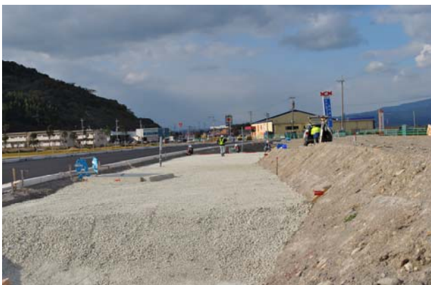
▲敷き均し転圧後
