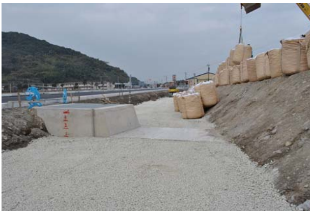
▲投入敷き均し
