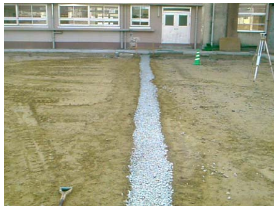
▲配水管埋設後
