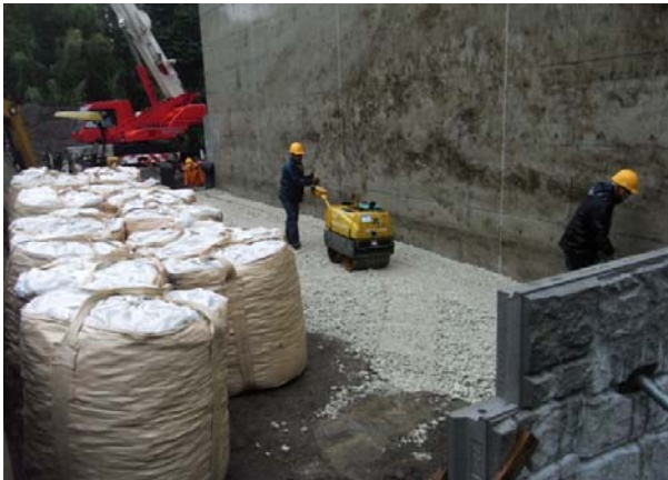
▲転圧（1 t 振動ローラーで概8回）
