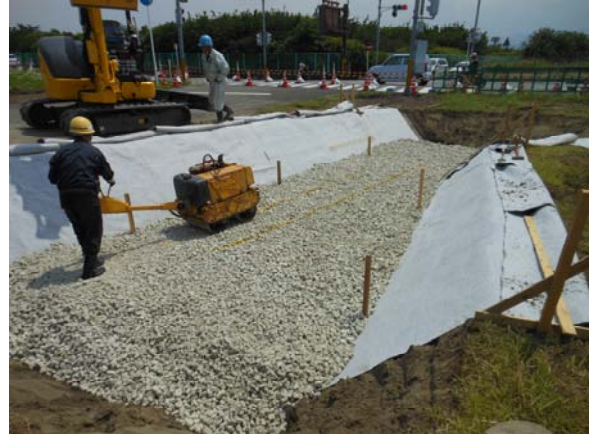
▲転圧状況 (ハンドガイド 0.6 t 振動ローラー)
