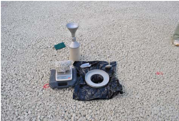
▲試験孔掘削（ビニールシートで覆った状態）
